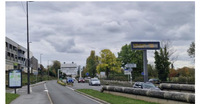
Requalifier les voies routières incompatibles à la qualité historique de la zone tampon
