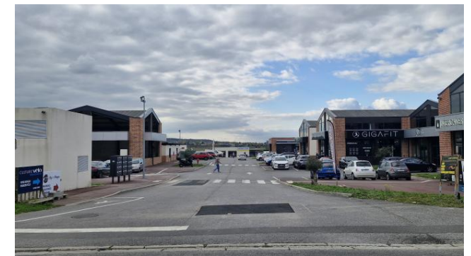
ZAC SANTOS DUMONT à Saint Cyr L'Ecole en cours
