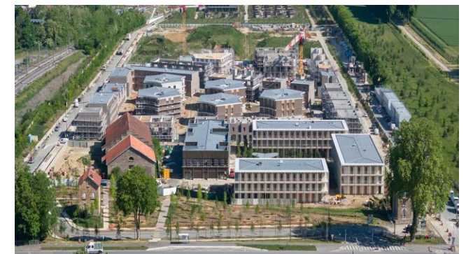
Site du Quartier de Gally à Versailles en cours
