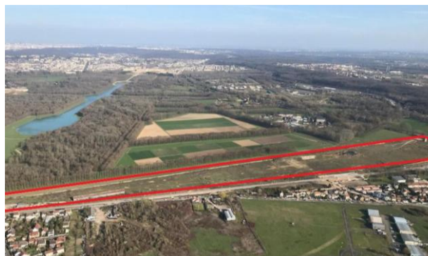
Site du Quartier de Gally à Versailles en cours
